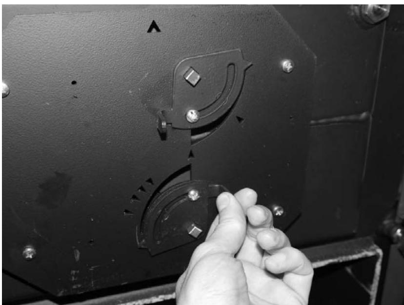
Nastavenie kotla DPX pre spaľovanie **peliet** (primárna a sekundárna klapka uzavorená).
